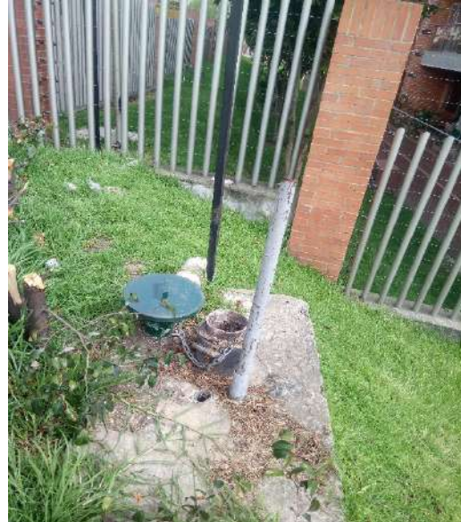
Fotografía 6. Vista pozo-11-0014, tapón acero.
