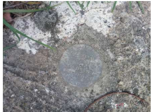
Fotografía 4. Placa identificación del pozo pz-11-0014.
