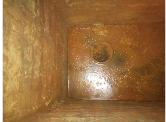
Fotografía 2. Estado actual del pozo pz-11-0015.
